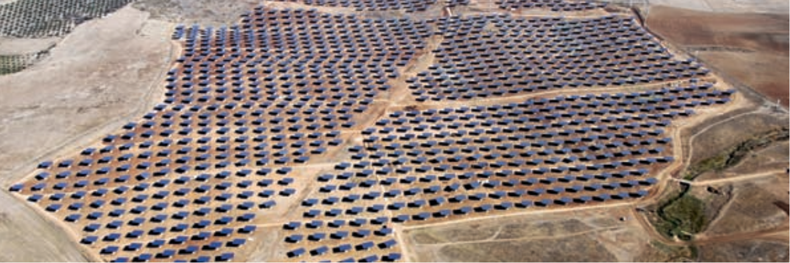
Die Deutsche Bank finanziert den weltgrößten Photovoltaik-Park „SPEX“ in Spanien: klimafreundliche Energie für 16 000 Haushalte
